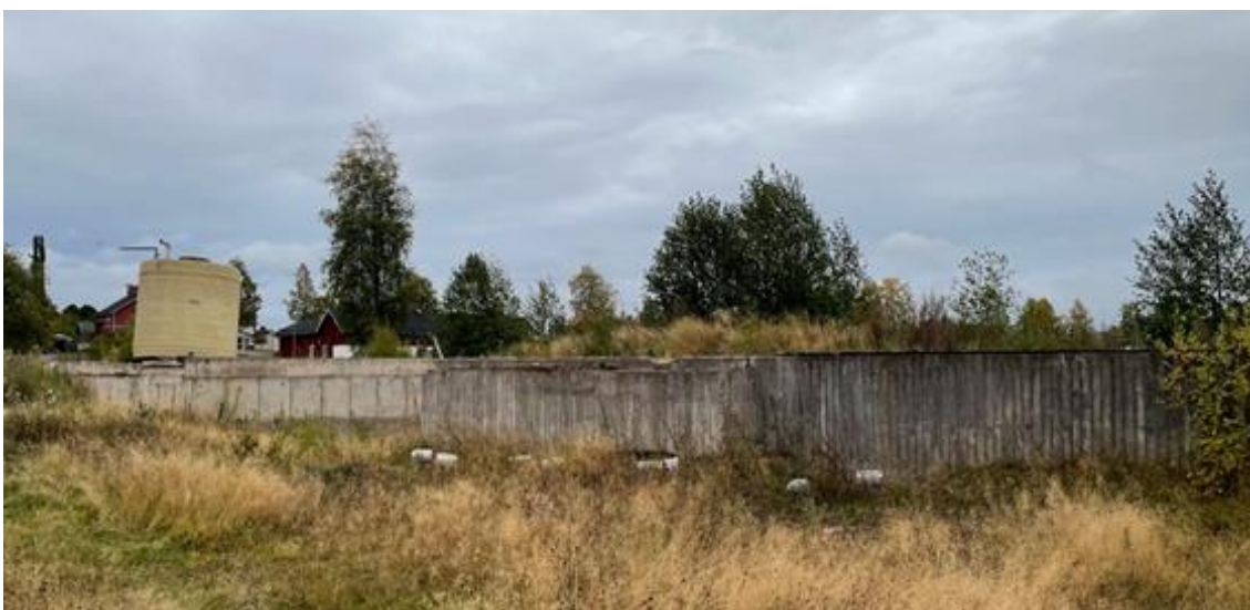
Figur 6. Grunden till det gamla reningsverket på den södra delen av fastigheten. Foto: Tyréns.
