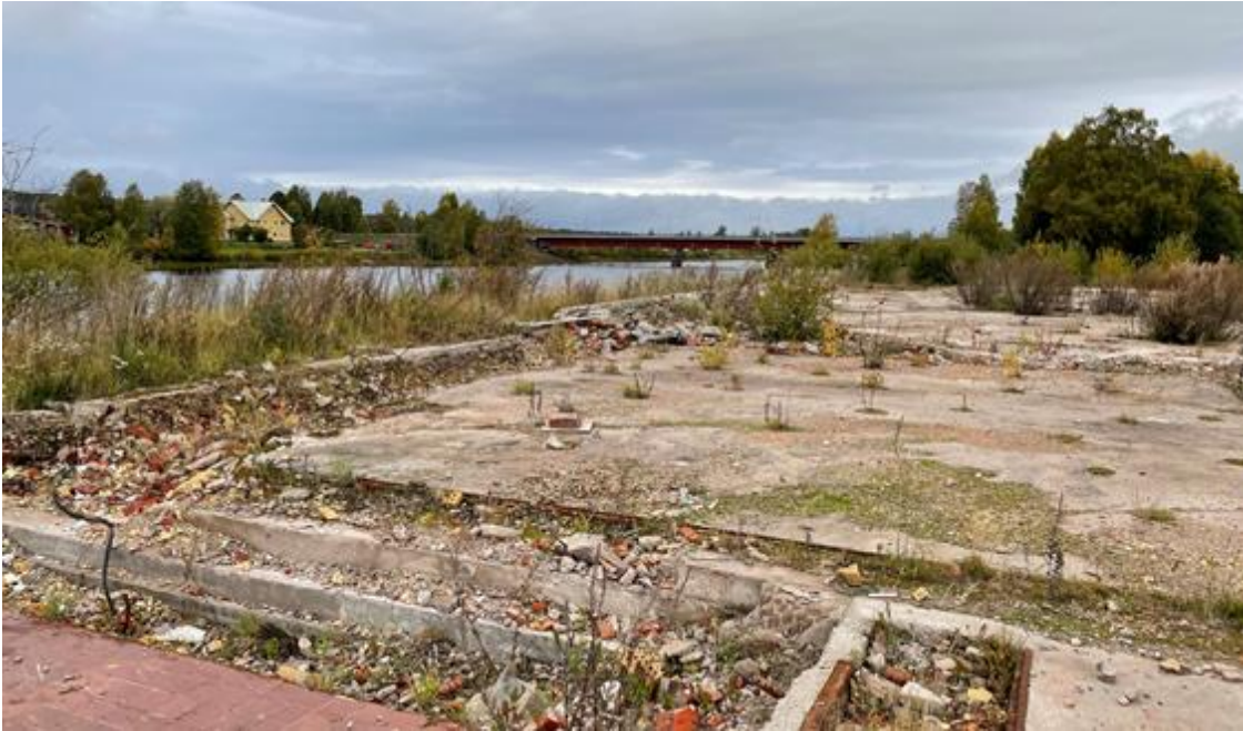
Figur 20. Den västra delen av betongplattan. Foto: Tyréns.
