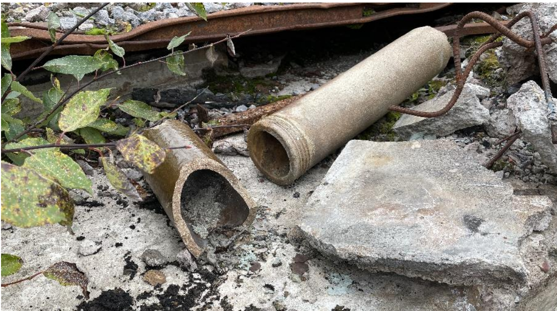
Figur 23. Rester från det gamla ledningssystemet, med slamrester kvar i rören.. Foto: Tyréns.
