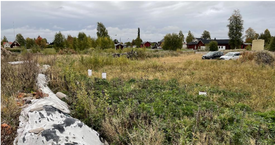
Figur 19. Det sanerade området där tidigare oljecisternerna funnits. Tre kontrollbrunnar skymtar i gräsområdet. T.v. i bild syns slutet på betongplattan som "vallats" in med geotextilduk i syfte att förhindra återkontaminering av redan sanerade områden. Foto: Tyréns.
