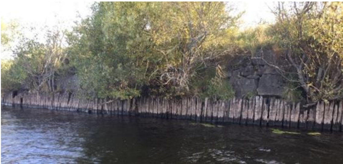
Figur 8. Stenskoningen ut mot Västerdalälven som delvis är igenvuxen med sly. En träpallisad löper längs större delen av stenskoningen. Foto: Tyréns.
