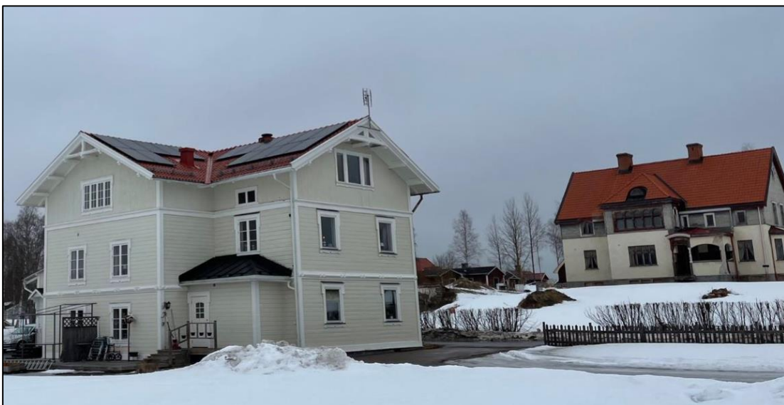
Figur 35. Bostadshus på fastigheten Huden 2, Åsbyvägen 8, till vänster i bild. Byggnad med bedömt behov av lokala bullerskyddsåtgärder. I bakgrunden ses byggnad (vilken är obebodd) tillhörande fastigheten Grönland 51:1. Foto: Tyréns
