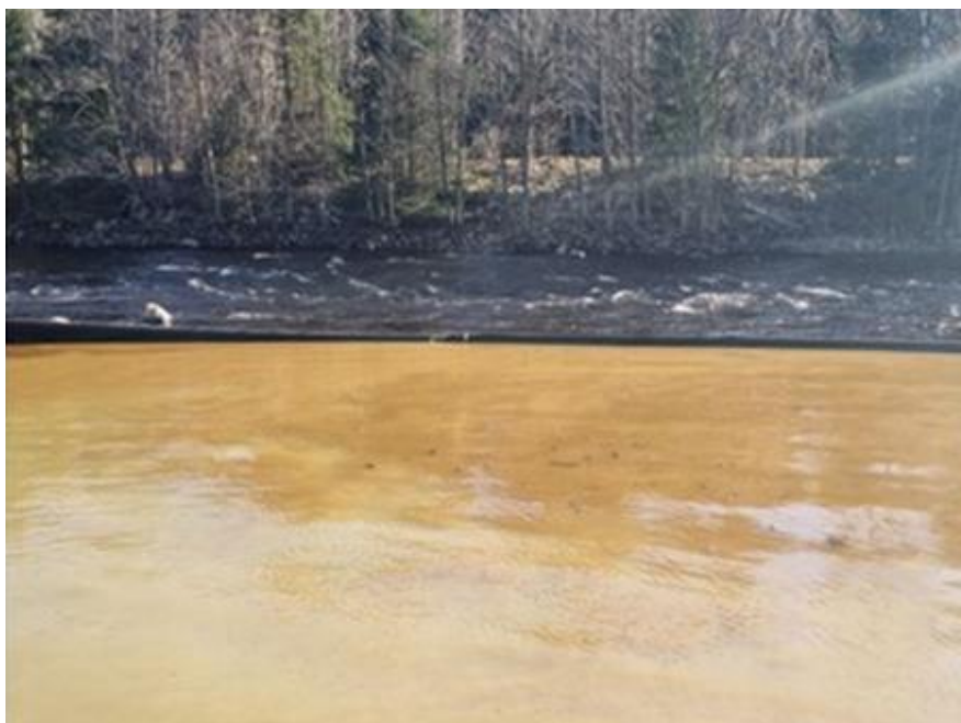
Figur 20. Siltgardin utlagd i Nissan vid Hultafors (Foto: Tecomatic)
