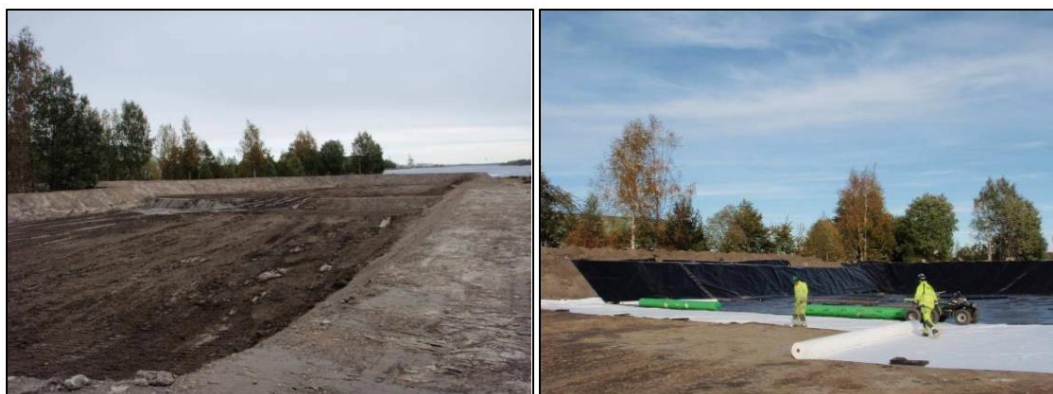
Figur 18. Exempel på anläggande av avvattningsyta. Till vänster invallad och till höger installation av HDPE-duk med underliggande geotextil. (Hämtad från SGU, 2019)
