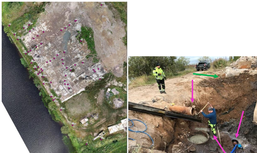
Figur 12. Samtliga identifierade brunnar inom området (t.v.) och foto från genomfört schaktarbete direkt söder om betongplattan (t.h.). Betongplattans sydvästra hörn är markerat med grön pil. Rosa pilar markerar påträffade rör vid olika nivåer. I mitten av bilden finns också en brunn som håller på att fyllas med cement.
